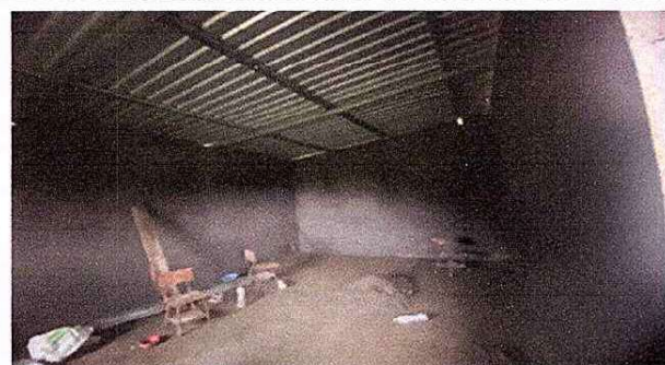
Foto 3: SUSTITUCION DE PARED EN PROCESO
