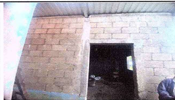
Foto 2: SUSTITUCION DE PUERTA EN PROCESO
